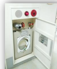
消火栓など防災 設備点検
